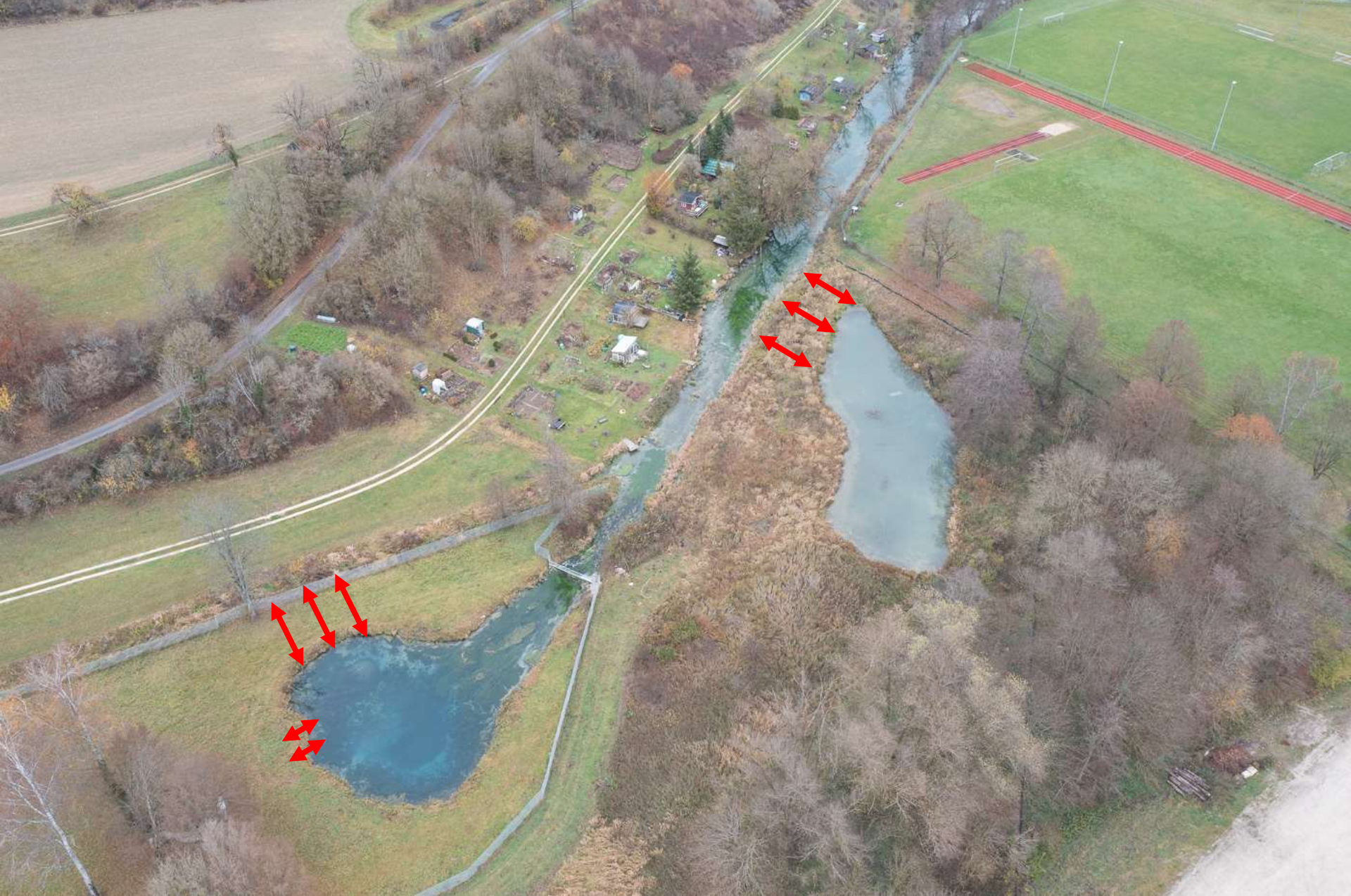
Einbau Biberschutzgitter: Kesselbach (Quelltopf=Zone 1)
