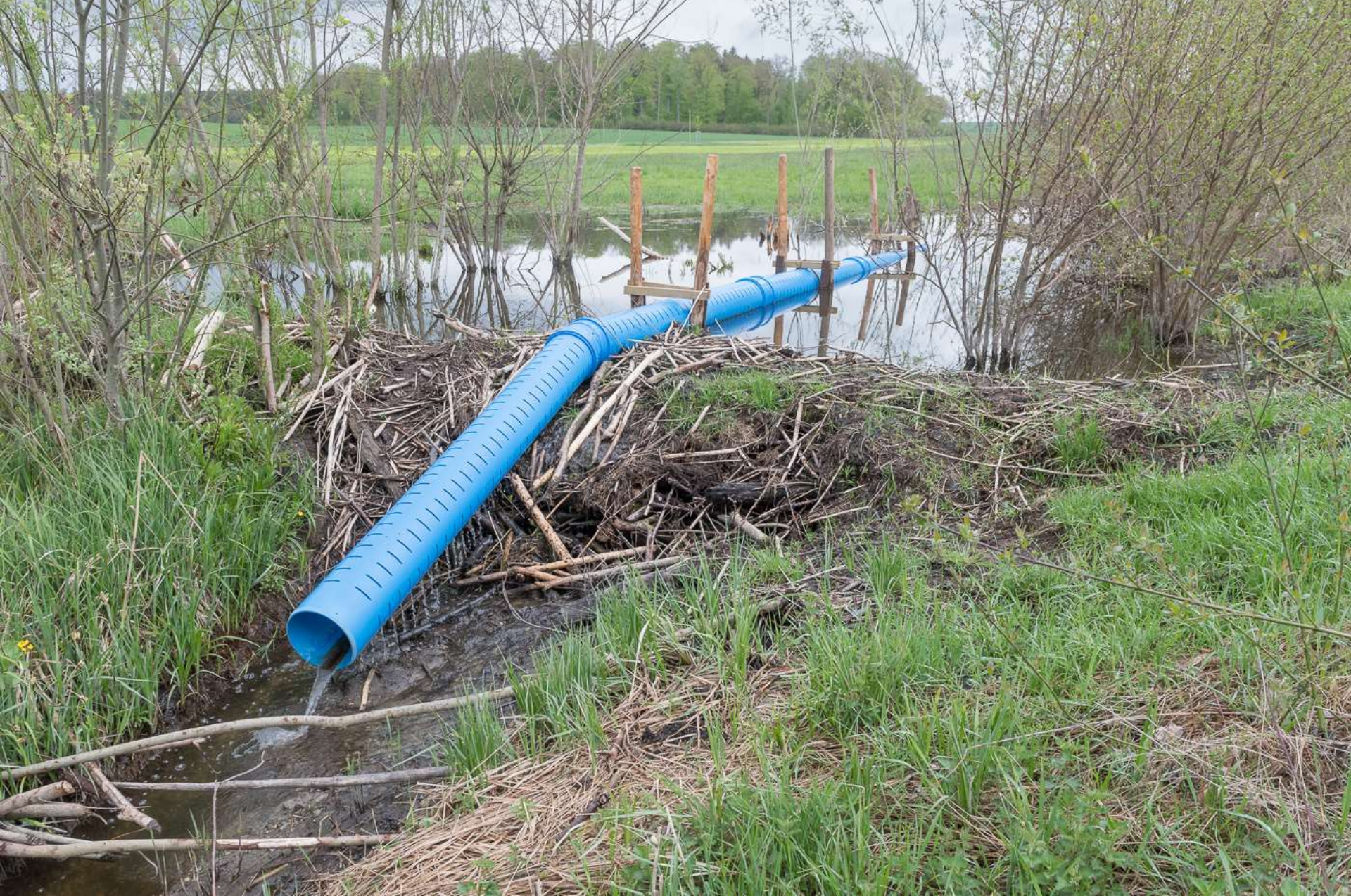
Einbau einer Dammdrainage
