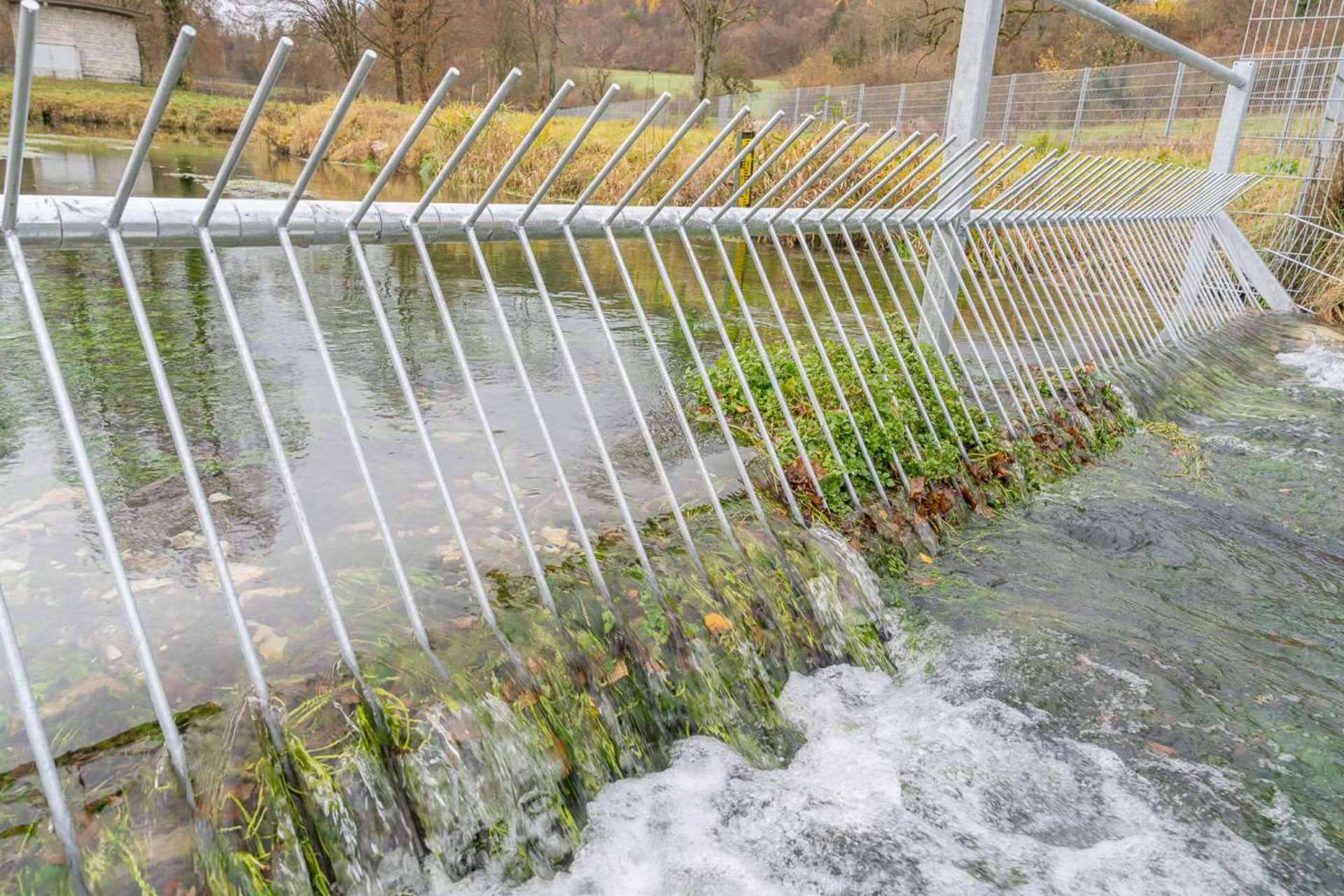
Absperrgitter in Fließgewässer (wartungsfrei)
