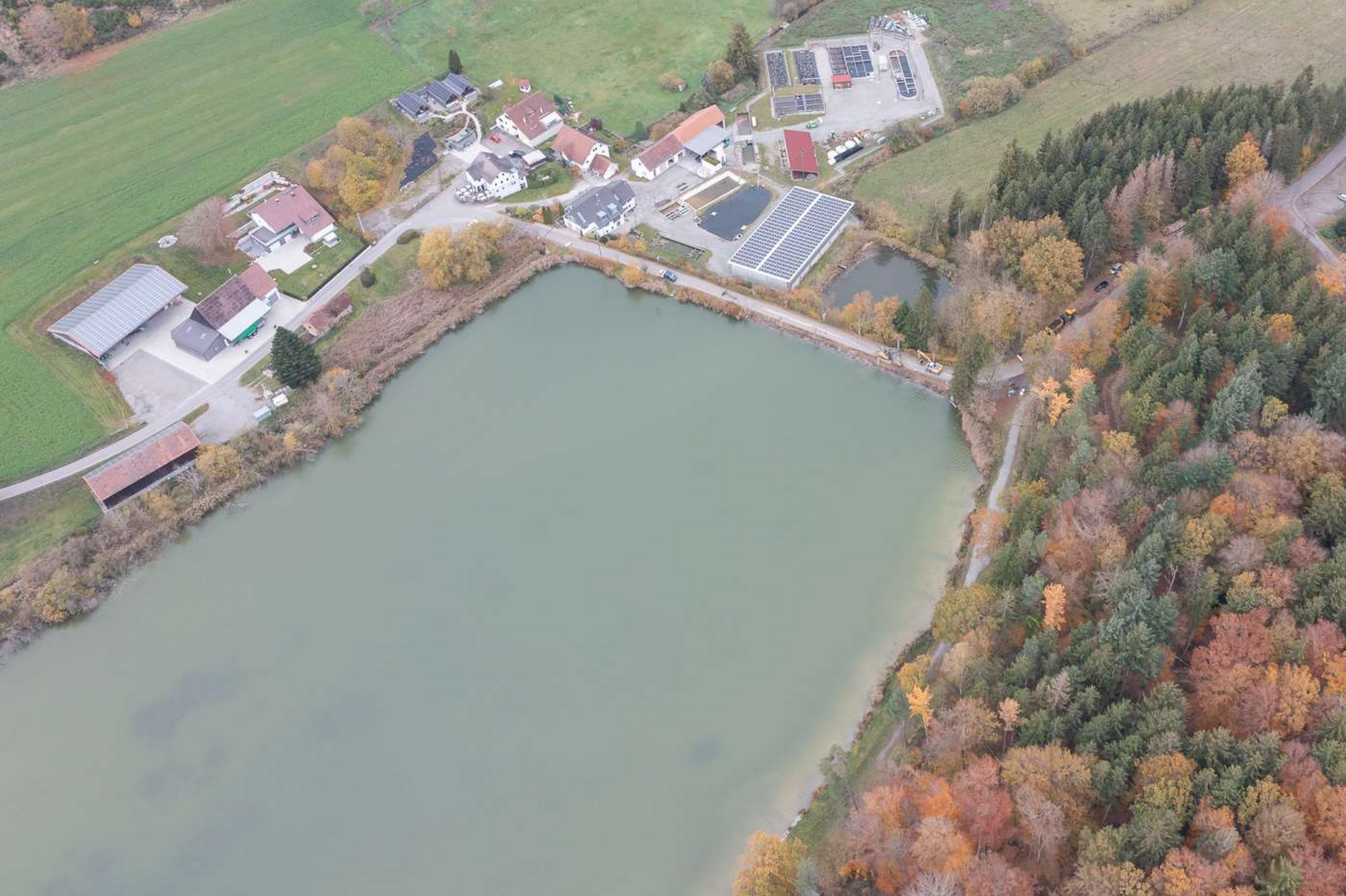
Einbau Biberschutzgitter in Wagenhauser Weiher
