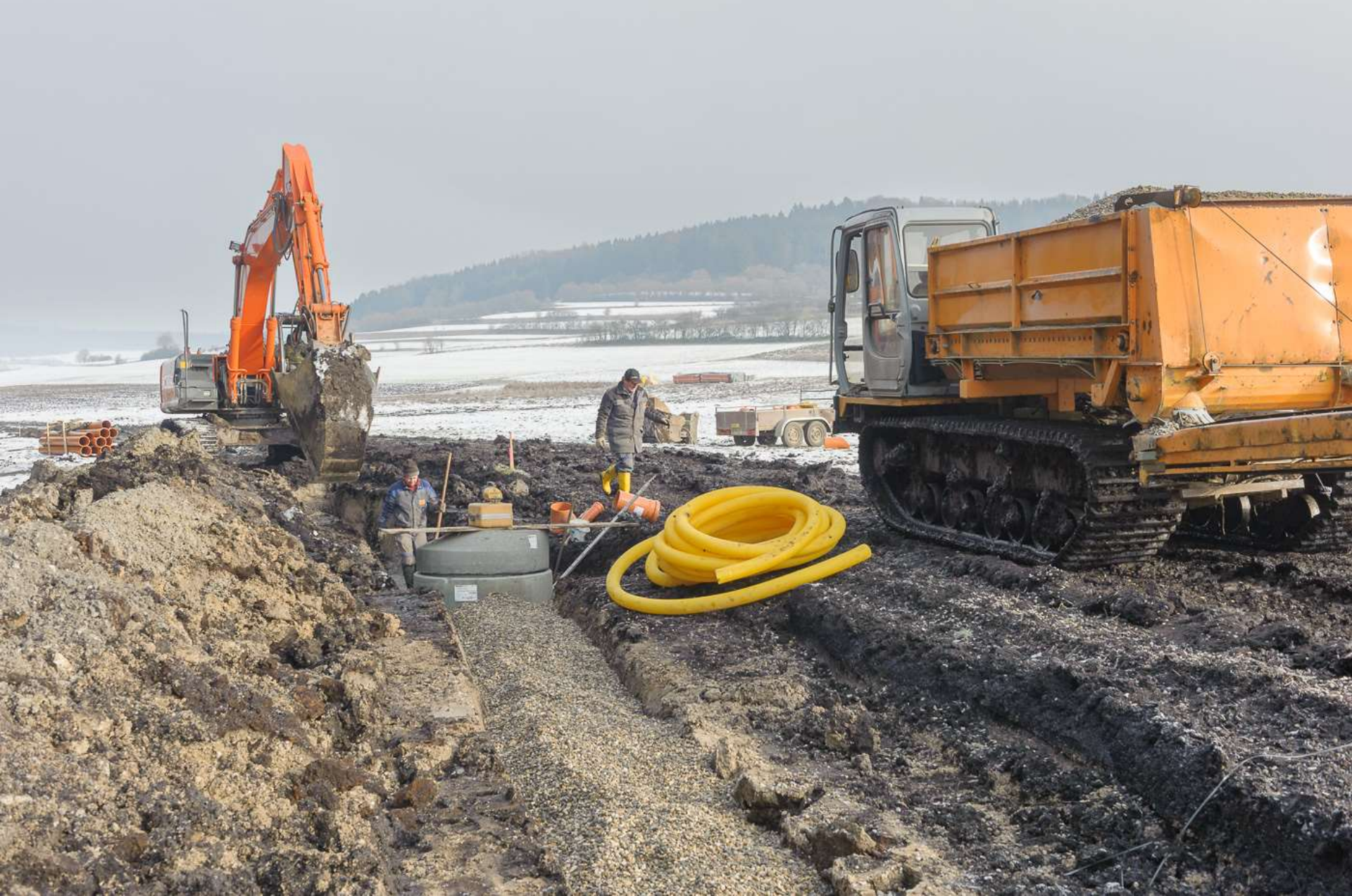
Bau der Fangeleitung
