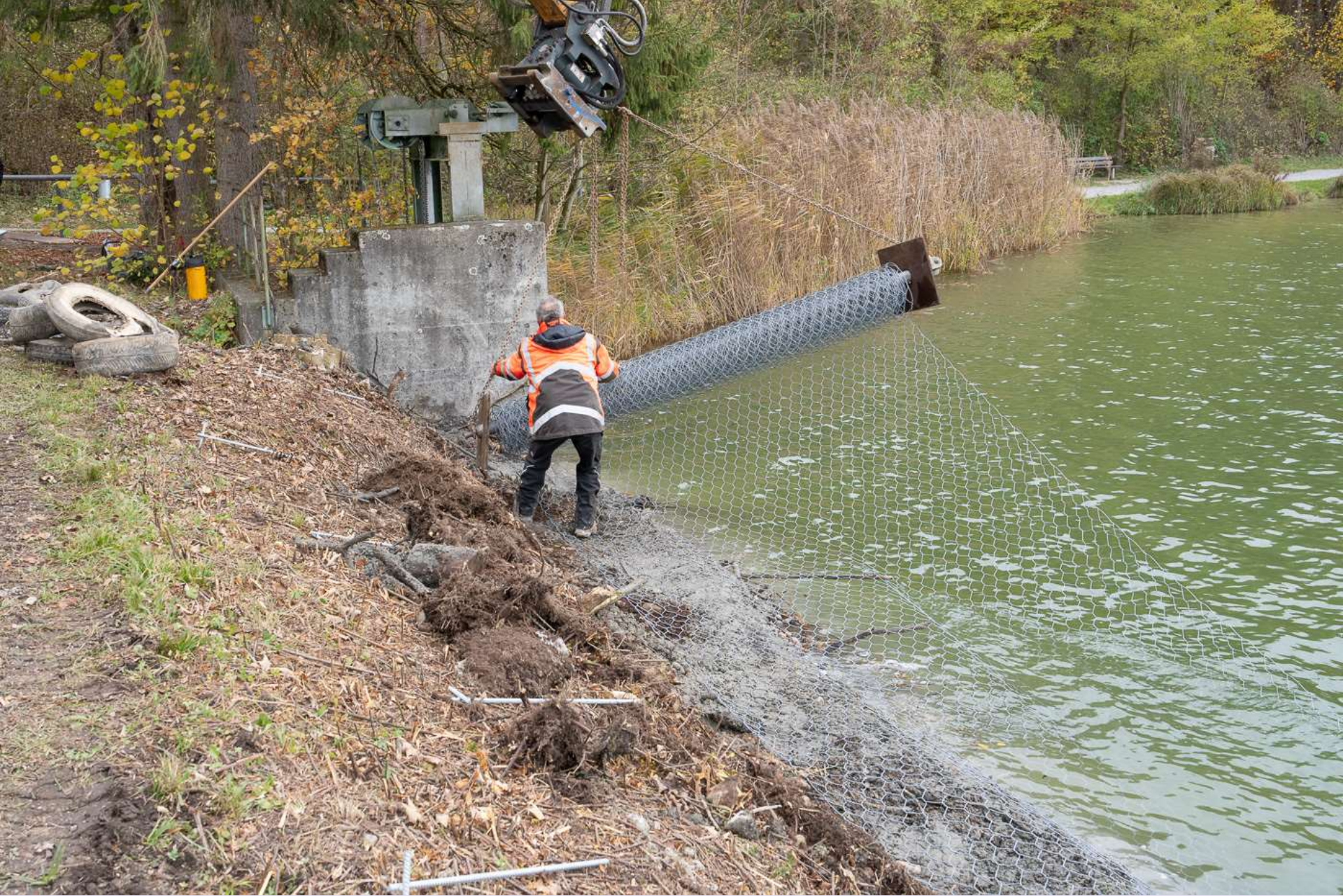
Herstellung Planie (Ufer abflachen) – Auflegen Gitter
