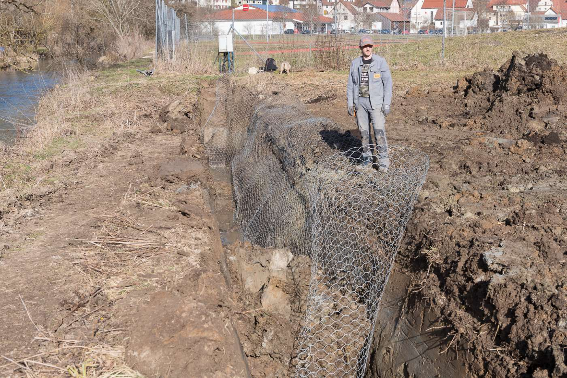
Senkrechter Einbau wegen Gewässerausbau
