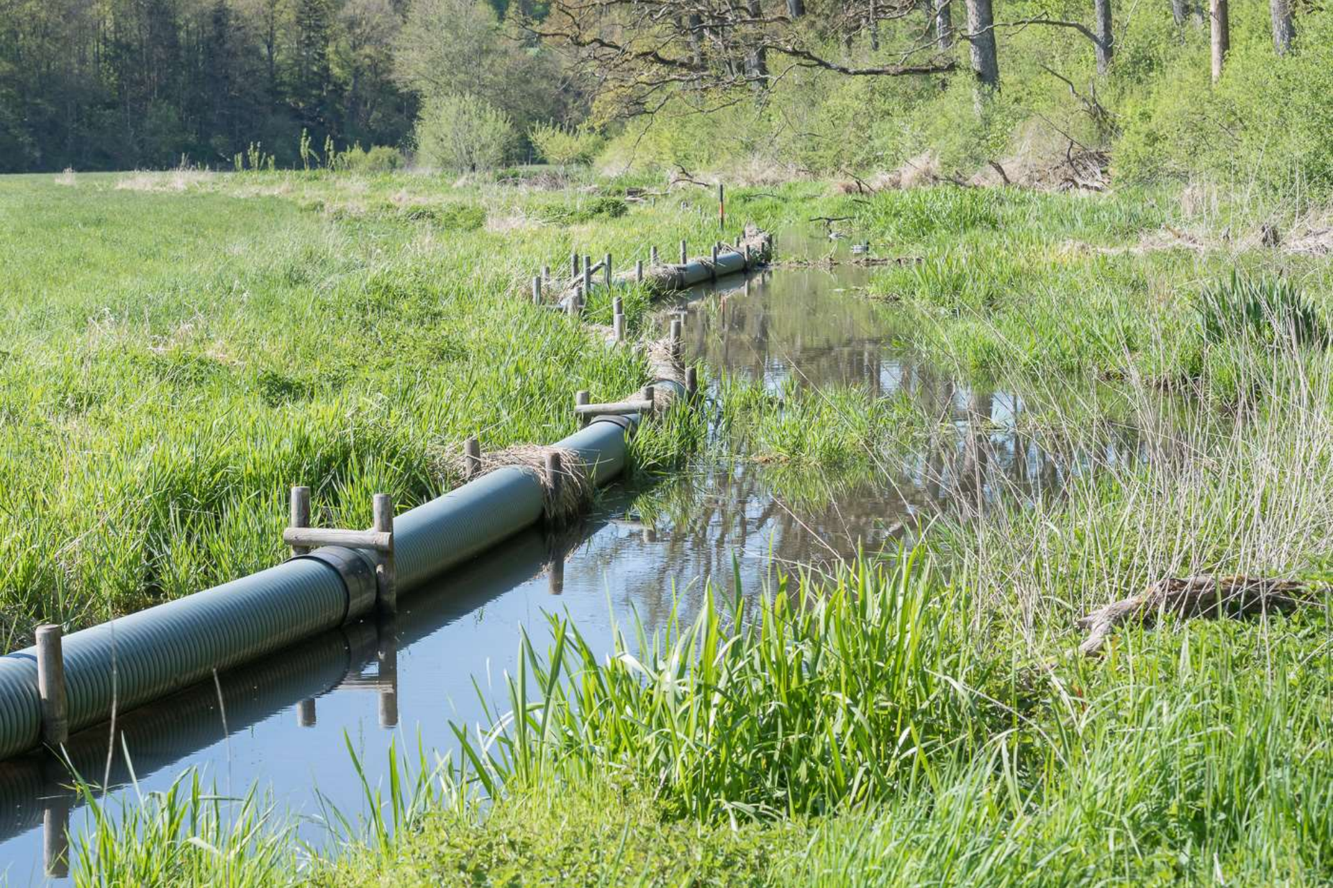
Vollsickerrohr auf Grund unterstrom einer Kläranlage
