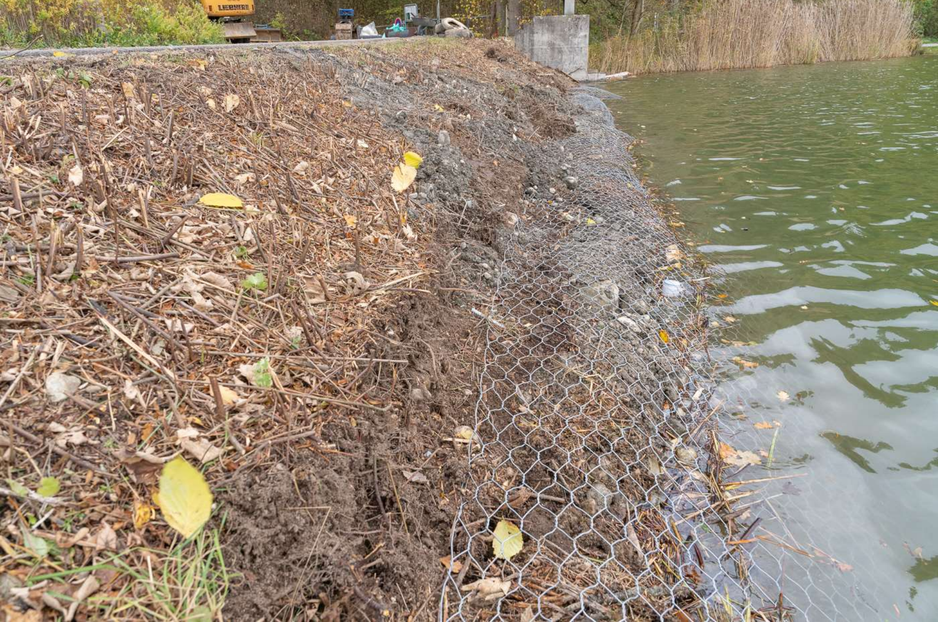
Gitter verlegt und fixiert
